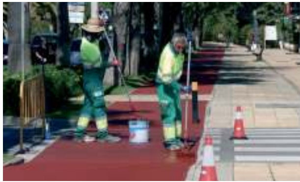
Trabajadores pintando el carril bici.
