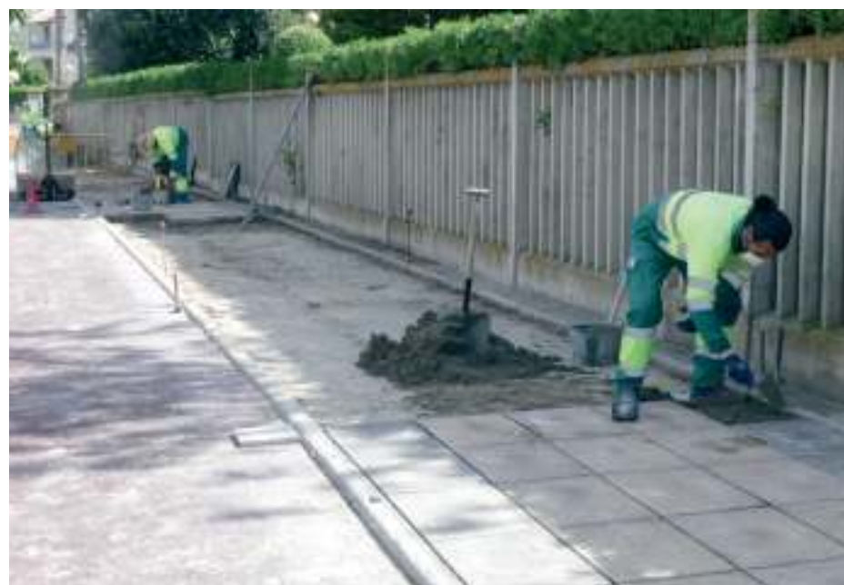
Trabajos de sustitución del pavimento en avenida Reina Sofía.
