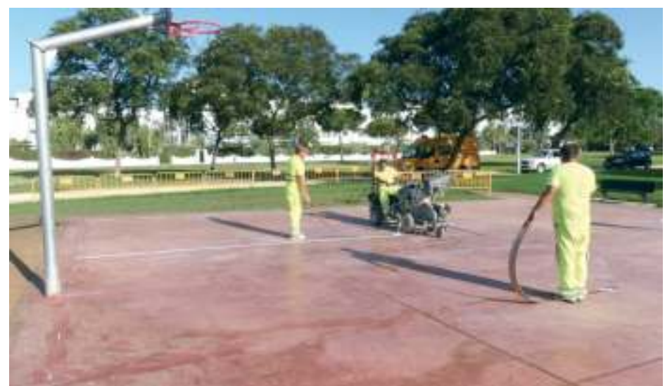
Operarios trabajando en la remodelada cancha de baloncesto.
