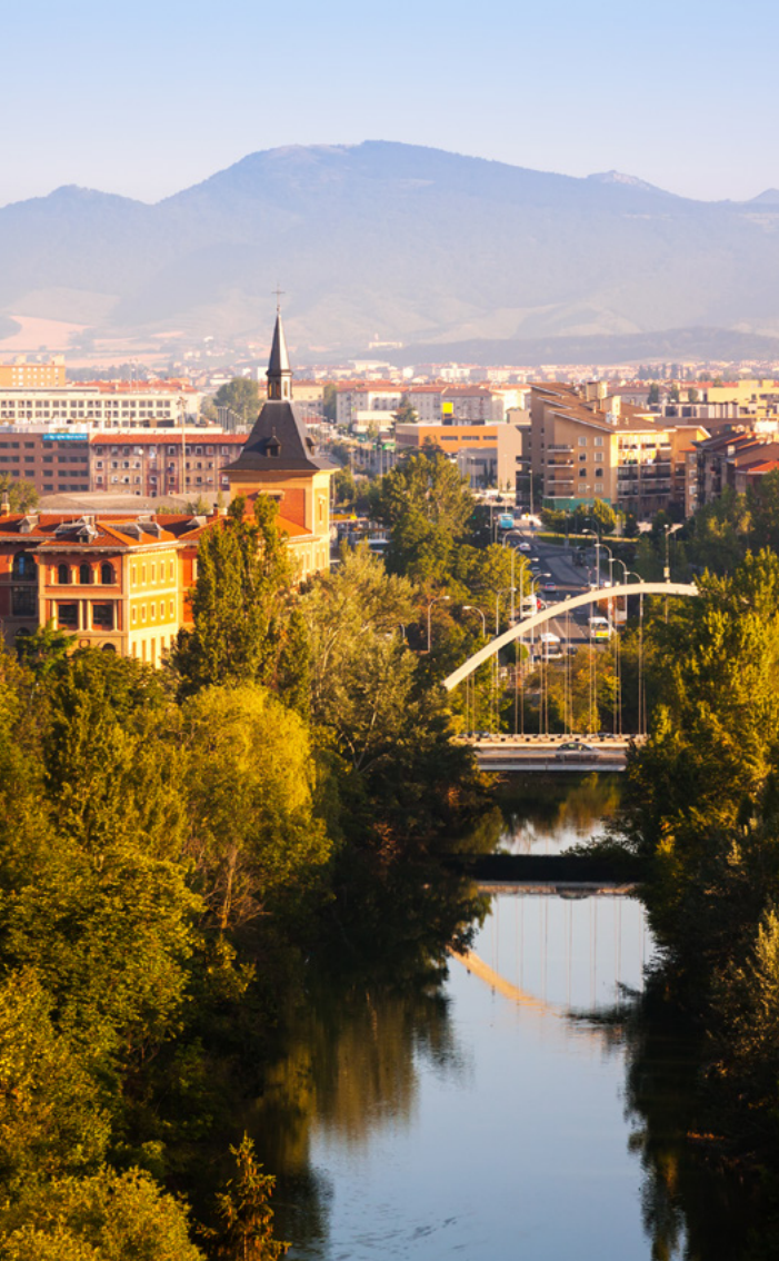
Puente sobre el río Arga. Pamplona
